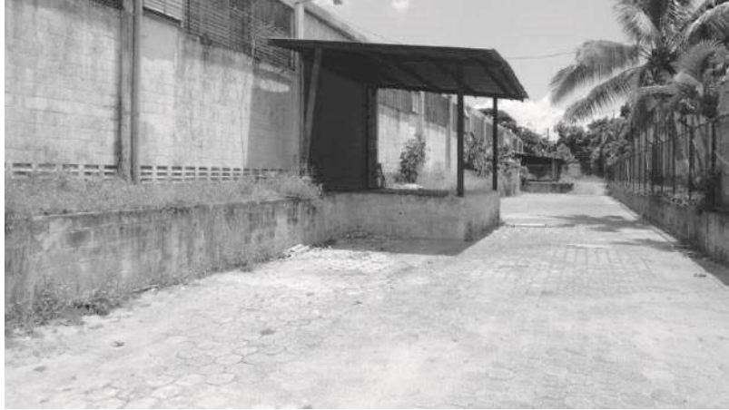
Fotografía 3. Bodega a 50 metros: 3,000 m 2 , 3 muelles.
